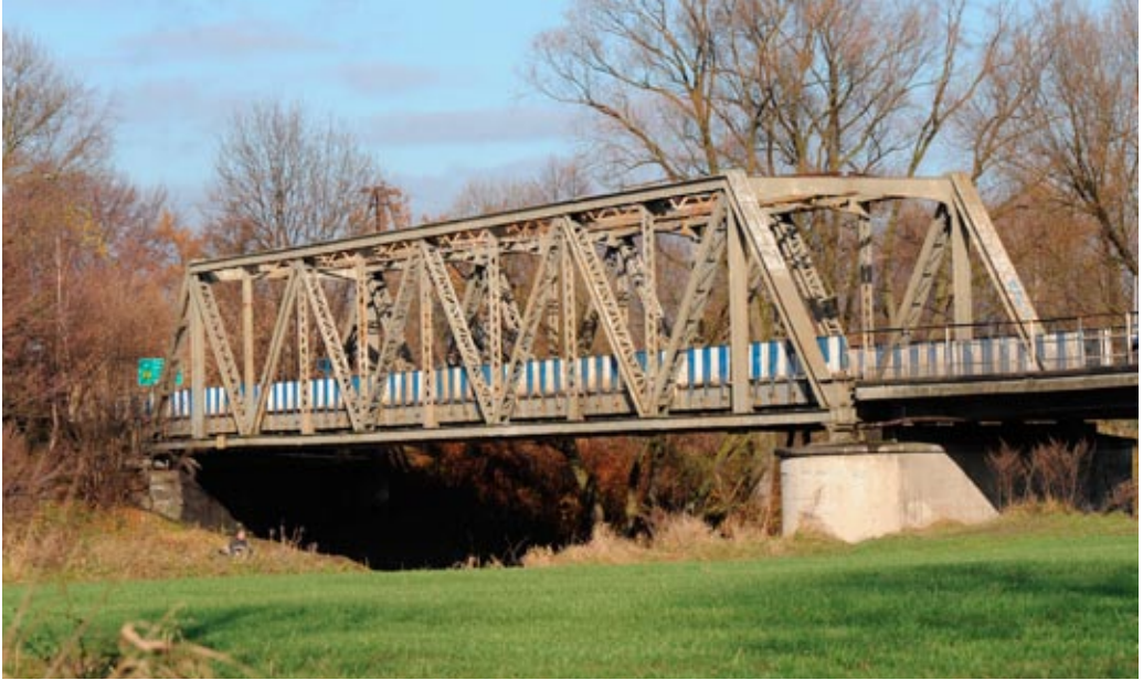
Żelazny most drogowy na Wiśle w Strumieniu, zbudowany w 1911 r.
