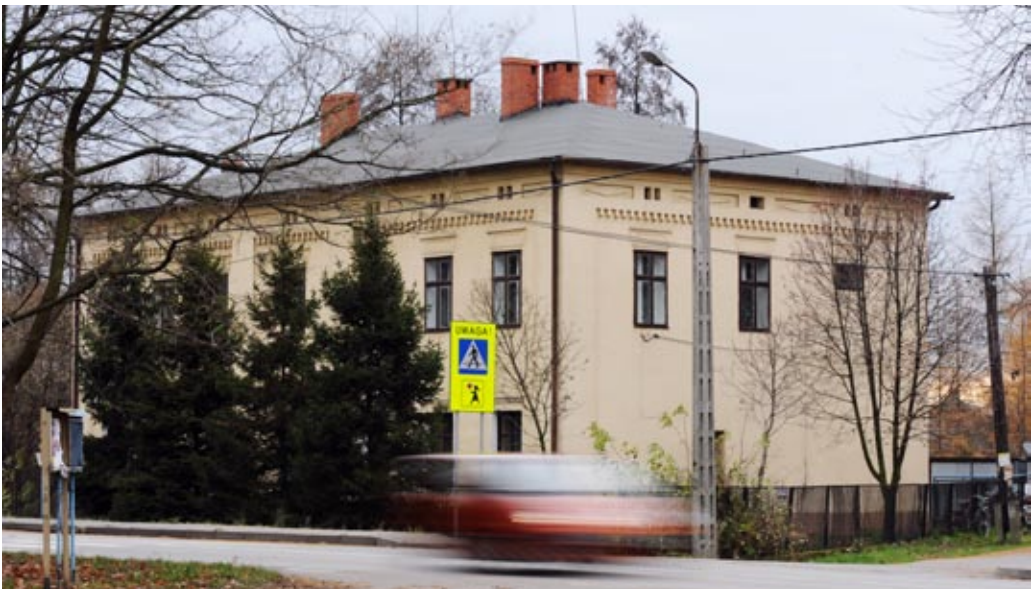
Budynek „starej szkoły” z 1870 r. w Zabłociu, przy ul. Bielskiej.
